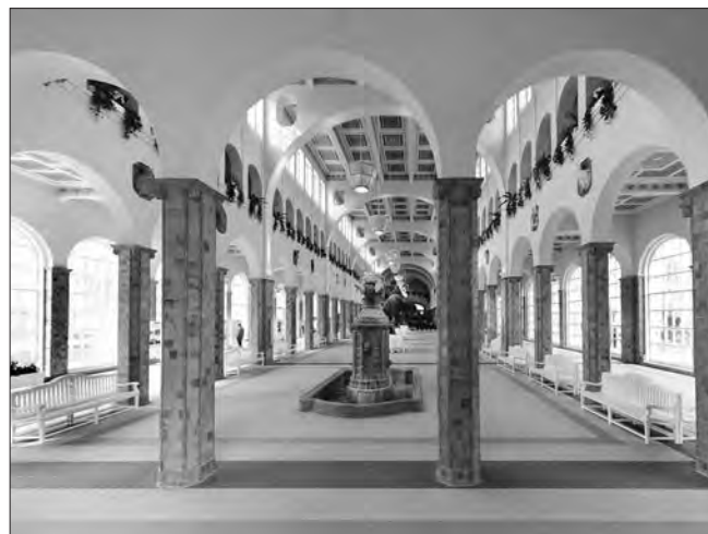
Nemško termalno zdravilišče Bad Kissingen ima poleg drugih stavb ogromen Wandelhalle (1910-1911), ki je zasnovan kot triladijska bazilika. Spletni vir: Bad Kissingen, Wandelhalle ; https://de.wikipedia.org/wiki/Wandelhalle_(Bad_Kissingen) , 30. 4. 2017.
