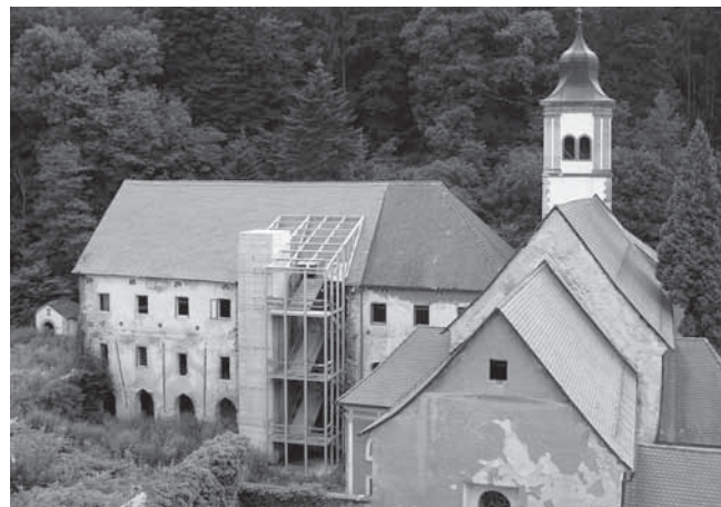
Grad Otočec. Sodobna skeletno-steklena konstrukcija dvigala je novo »transparentno« dopolnilo srednjeveškega gradu.
