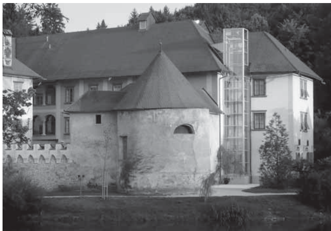
Studenice, nekdanji samostan dominikank. Ob nekdanjo klet in kaščo so prizidali stolp za dvigalo in stopnišče. Zelo groba devastacija nekdanjega dvorišča križnega hodnika.
