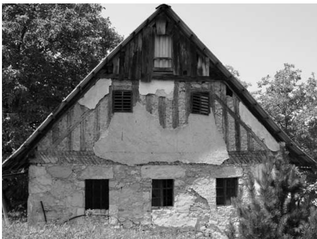
Tipična gradnja na štamberg, Pečje 12. Foto: Tina Lorbek, Sevnica, 14. 7. 2009
