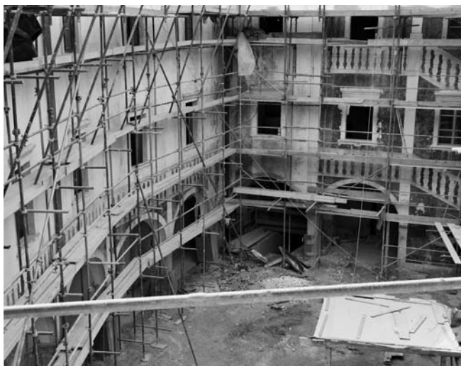
Grad Rajhenburg v obnovi.
