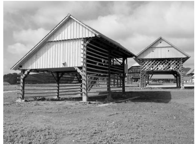
Obojnice in rante so najbolj izpostavljeni deli kozolcev. Na Breznikarjevem kozolcu na kozla (spredaj) so bile v glavnem rekonstruirane.
