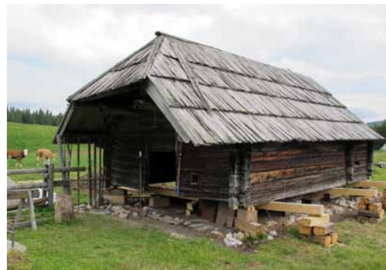
Knoflnov stan v času obnove.
