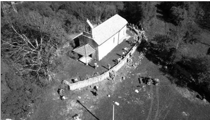
Rekordna obnova dotrajanega suhega zidu srednjeveške cerkvice sv. Helene na Gradišču, Jurij Ažman, Gradišče, 2017, arhiv PŠJ.
